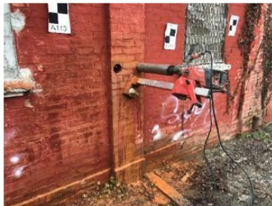
DM1 – Prelievo di carote di muratura
