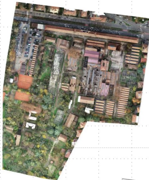
Ortofoto delle coperture eseguito con drone
