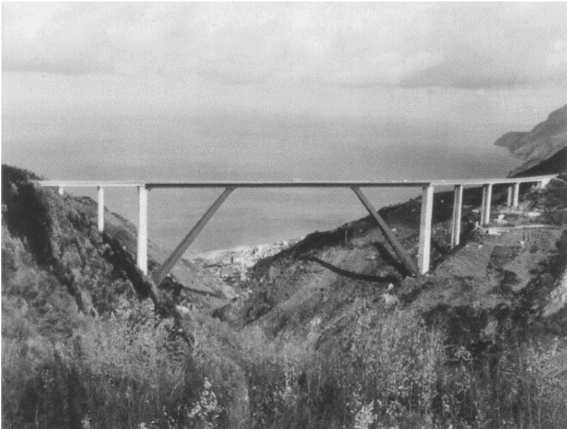
S. ZORZI, PONTE SFALASSÀ, AUTOSTRADA SALERNO-REGGIO CALABRIA, 1968-72
