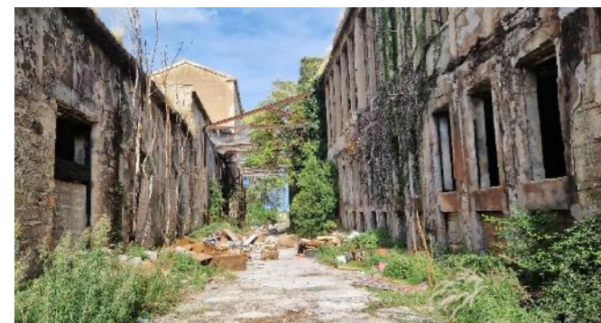
Edifici destinati alla produzione
